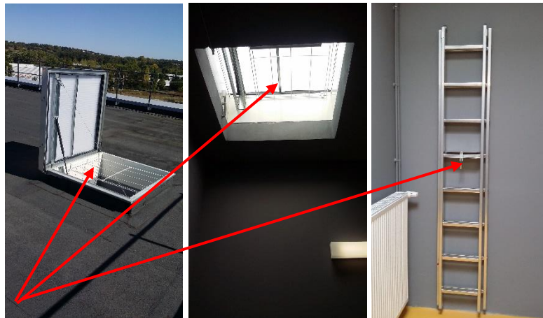
Lanterneau + échelle d'accès à la toiture terrasse (accès indépendant pour chaque bâtiment)
